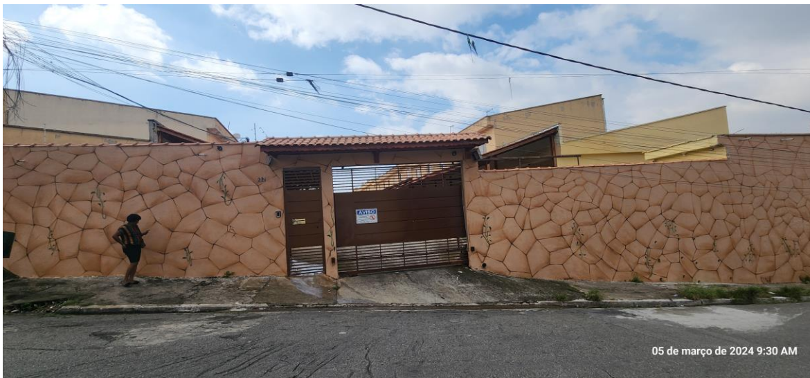
Figura 4 – Frente do imóvel.
